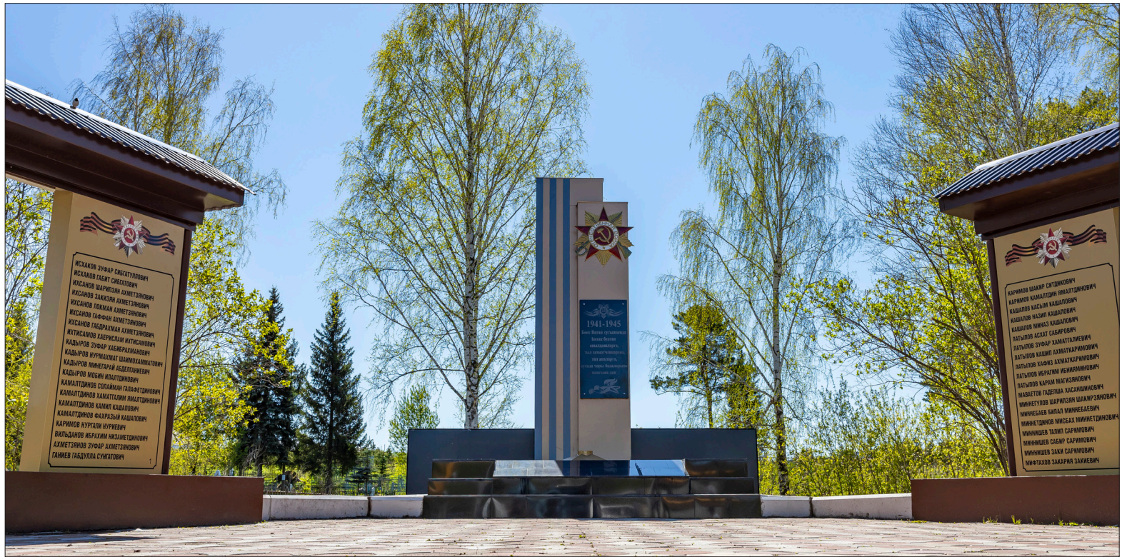
В селе Нижние Чершилы обновили фасад памятника участникам Великой Отечественной войны. Его облицевали плиткой и оштукатурили / ФОТО СЕРГЕЯ ТРУСОВА
